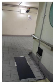
↑壁据え付け型アンテナ 及びマットアンテナ →
