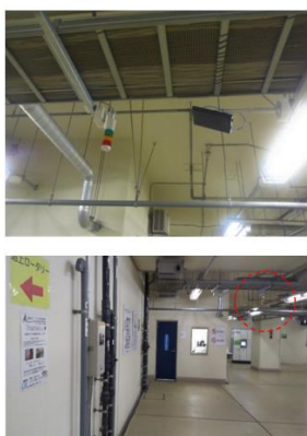
↑天井据え付け型アンテナ及びパトライト
